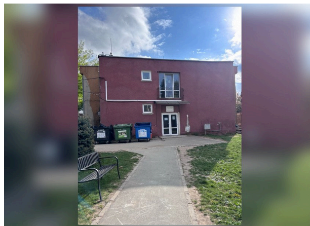
Budova mateřské školy na Masarykově ulici v Košicích.
