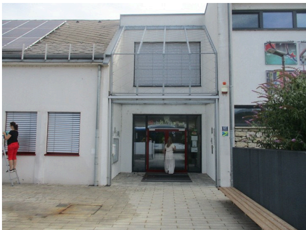
NÖ Landeskindergarten Wolfsthal stojí v příhraniční obci nedaleko Slovenska.
