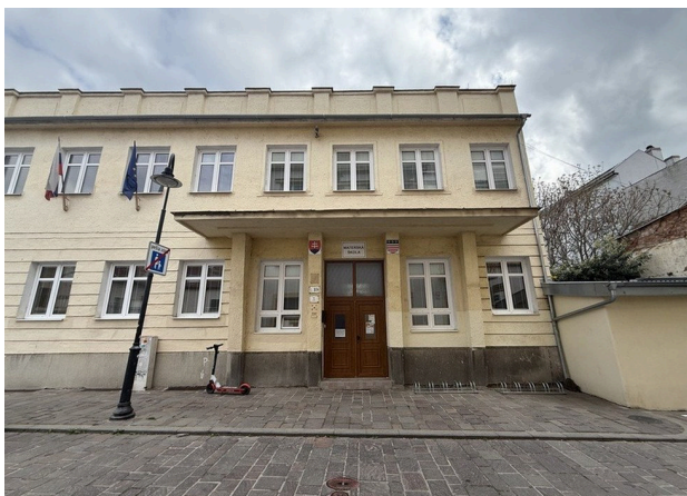
Budova Mateřské školy Hrnčiarska 1 v historickém centru Košic.
